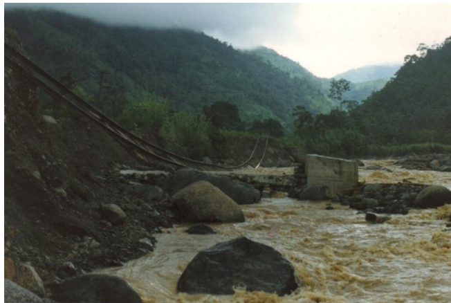
INUNDACIONES EN LA COSTA QUE LLEGÓ A LA DESTRUCCIÓN DE LAS LÍNEAS FÉRREAS EN 1884 (TOMADA DE ARCHIVOS FOTOGRAFICOS DE ANTONIO MALDONADO: QUITO-ECUADOR)
