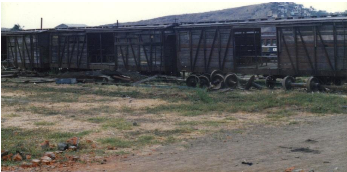
FERROCARRILES ABANDONADOS Y DETERIORADOS (TOMADA DE ARCHIVOS FOTOGRAFICOS DE ALFONSO MALDONADO: QUITO-ECUADOR)
