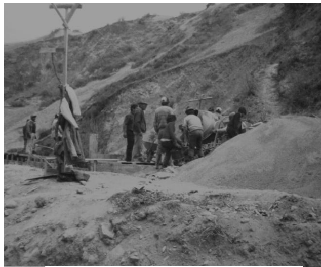
CONSTRUCCIÓN DEL LAS LÍNEAS FÉRREAS (TOMADA DE ARCHIVOS FOTOGRAFICOS DE ANTONIO MALDONADO: QUITO-ECUADOR)
