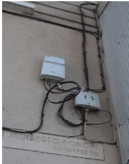
Figura 3.11 Punto de Distribución de red GPON en Montevideo - Uruguay. Fuente: Autores (Visita Técnica).
