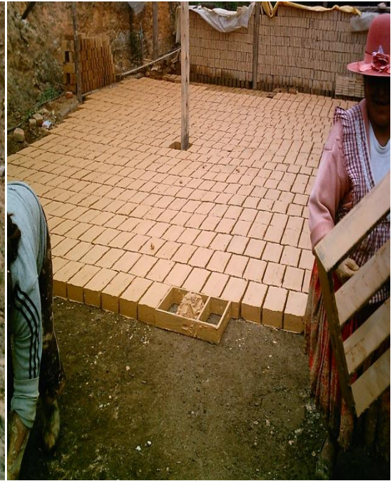
Imagen 11: Moldeado de ladrillos
