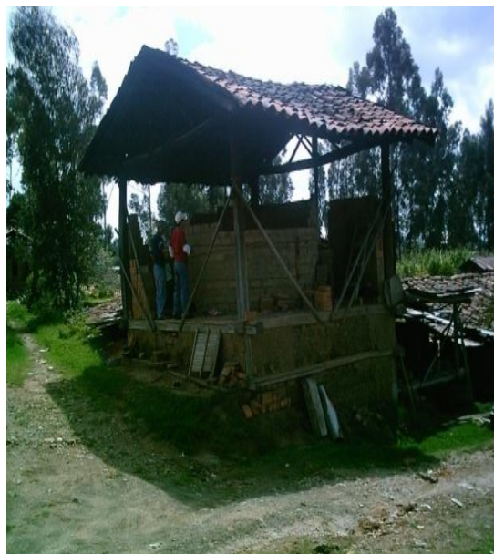
Imagen 6: Horno artesanal para ladrillos
