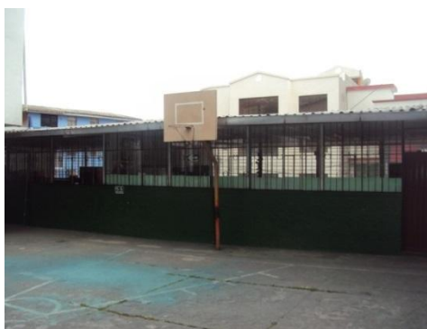
Figura 9: Infraestructura Bloque C
