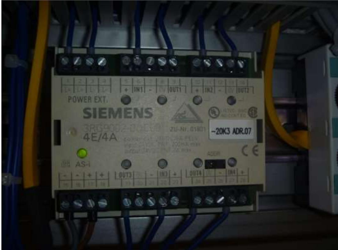
Figura 17: Módulo activo de Siemens
