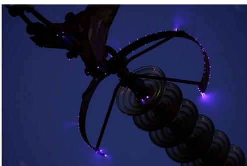
**Figura 45 Efecto Corona en una línea de Alta Tensión de 500 KV (nitrometano, 2013)**
