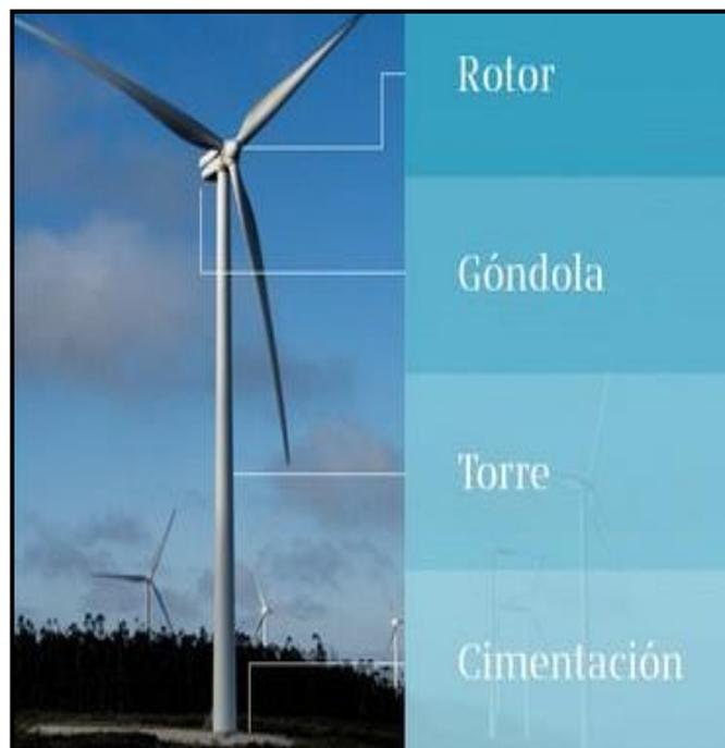
Figura 1.21: Elementos principales de un aerogenerador. Fuente [7]
