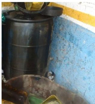
**Figura 31:** Fuga de aceite de depósito.
