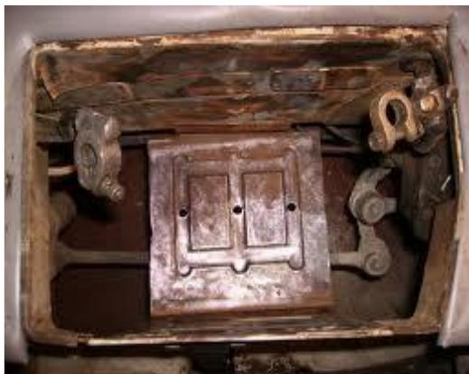
**Figura 5:**Corrosión producto del electrolito.
