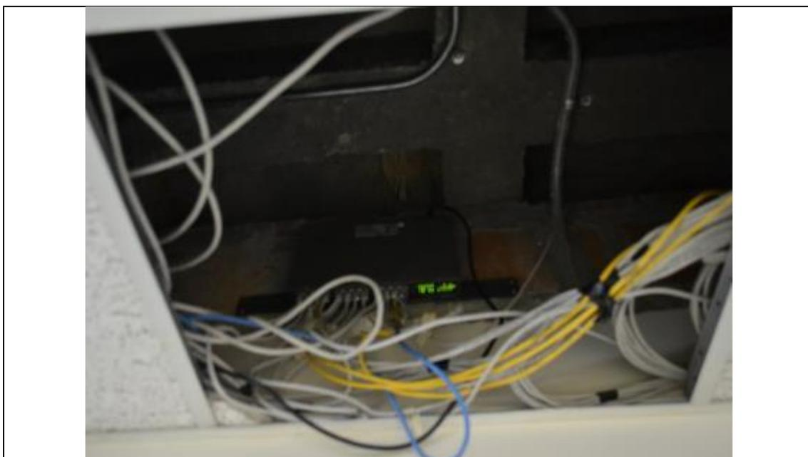
**Figura 63:** Switch incorporado en la pared sobre el techo falso.
