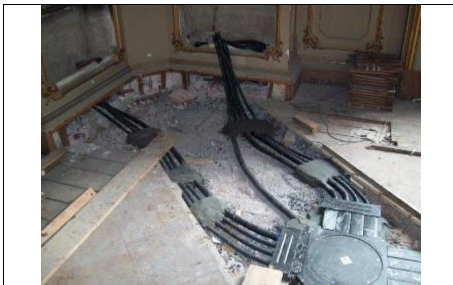
**Figura 9:** Ductos bajo el piso.
