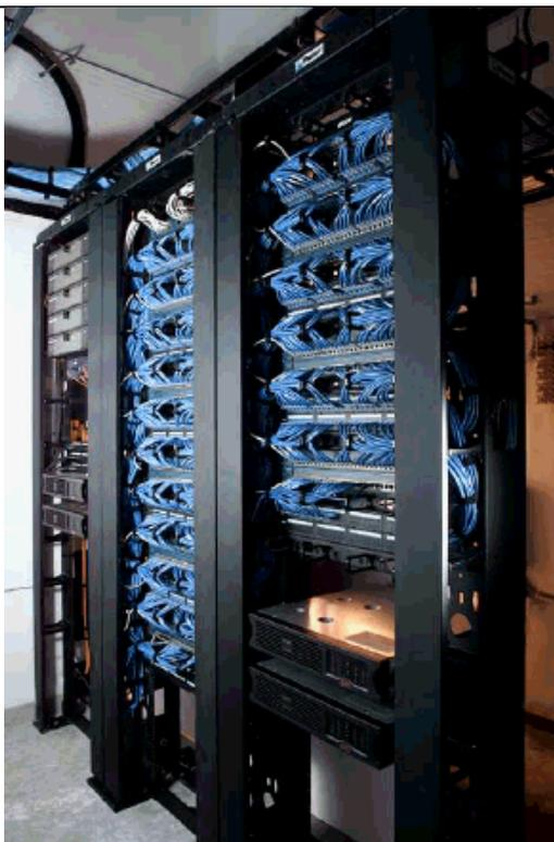
**Figura 60:** Distribución estructurada de cableado y equipos en un armario de telecomunicaciones.
