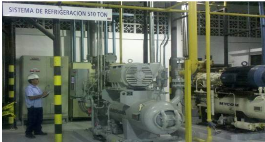
Figura 3.22. Toma de datos Compresores del Sistema de Frío 104
