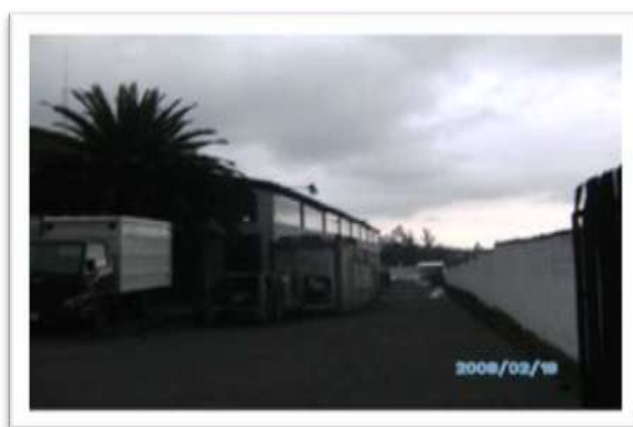
Gráfico 3 Instalaciones de la Empresa
