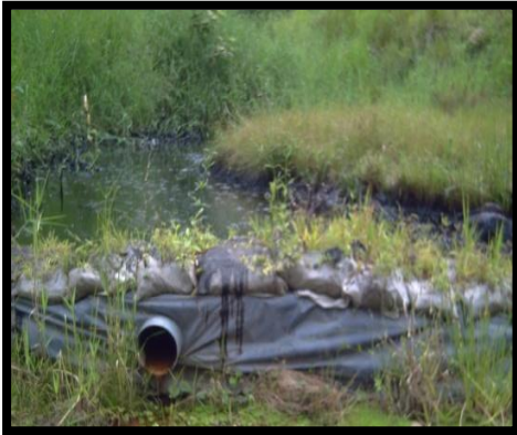
Estanque delimitado con geomembrana.
