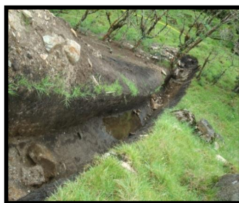
Proceso de remediación: Delimitación del lugar con prohibición de acceso y Zanjas de control de derrame.
