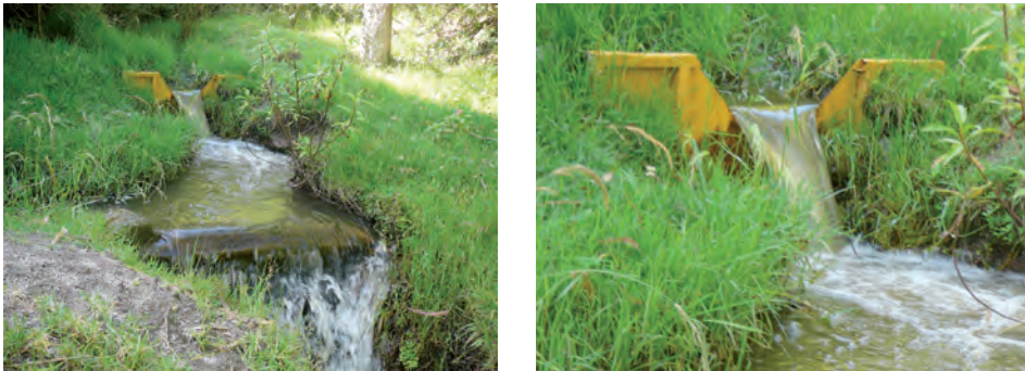
Figura 2. Medición del caudal de quebrada Yumacay- Vertedero Triangular de 90°
