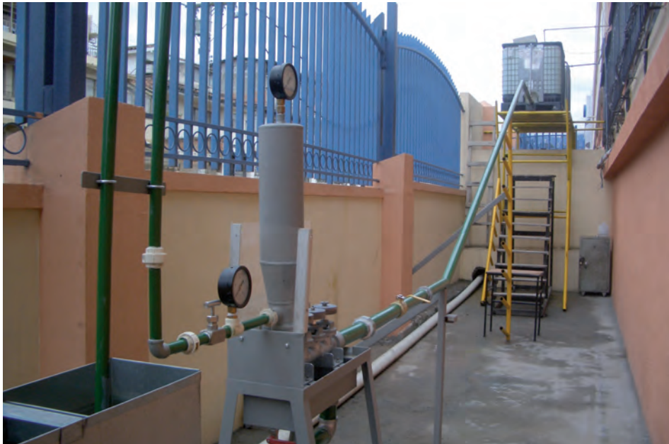
Figura 12. Banco para Pruebas de Bomba de Ariete Hidráulico
