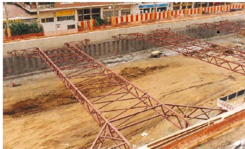
Fig. 1.11.- Pantalla de pilotes (cimentación profunda)
