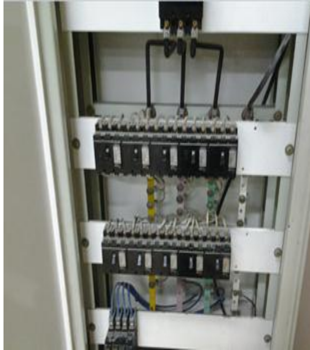
Figura 67.25 Instalaciones Laboratorio Sistemas Eléctricos de Potencia Fuente: Los Autores
