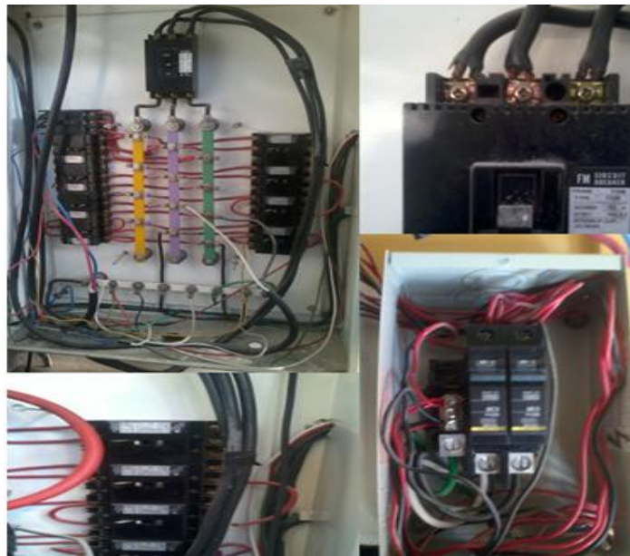
Figura 52.10 Instalaciones Laboratorio de Microbótica Fuente: Los Autores
