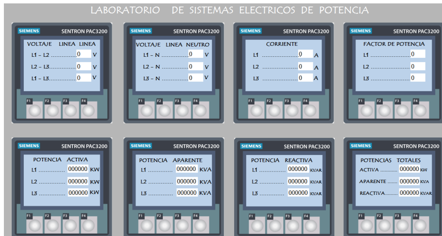
Figura 29.22 Imagen Corte Reconexión Laboratorios Fuente: Los Autores
