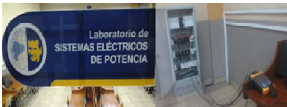
Figura 64.22 Laboratorio de Sistema eléctricos de Potencia Fuente: Los Autores
