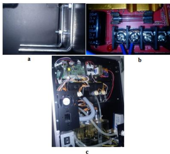
Figura 3.44 a) Base para la batería de respaldo. b) Sistema de alimentación con batería de respaldo y auto recarga. c) Sistema de alimentación ya instalado.
