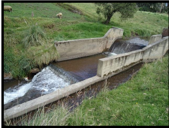
Figura 8: Condiciones del agua en el río Chimborazo
