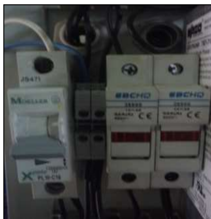
Figura 3.5 Fusibles de protección
