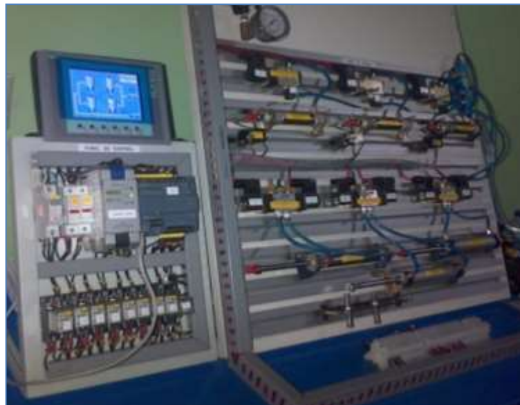
Figura 4.101 Panel de Control práctica#1
