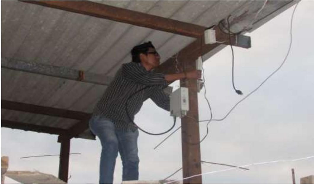
**Figura 12. Instalación de antena – Station WDS , Domicilio de docente**
