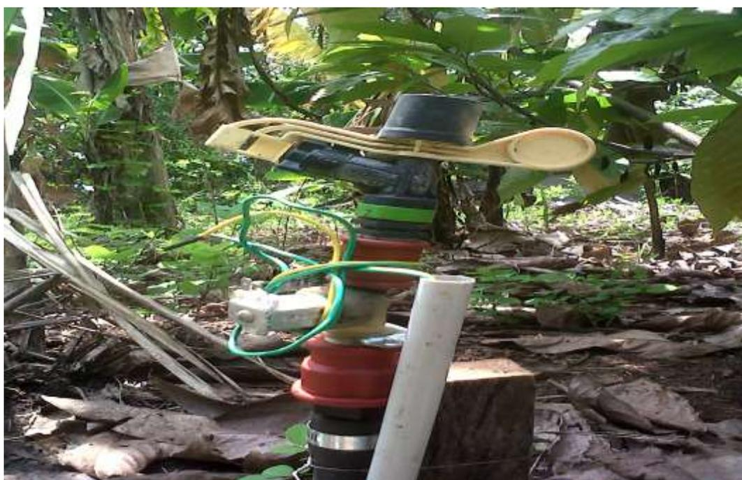
FOTO N° 8: ELECTROVÁLVULAS Y ASPERSORES PARA IRRIGACIÓN DEL
