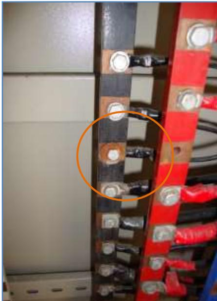
**FOTOGRAFÍA 3.37: ABERTURA INADECUADA DE CANALETA A TD-PISO #3**
