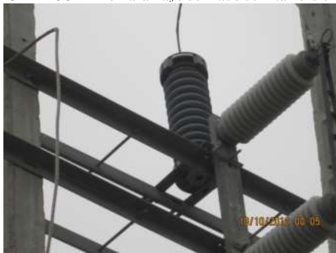
GRÁFICO III- 13 Pararrayo del Lado de Alta Tensión
