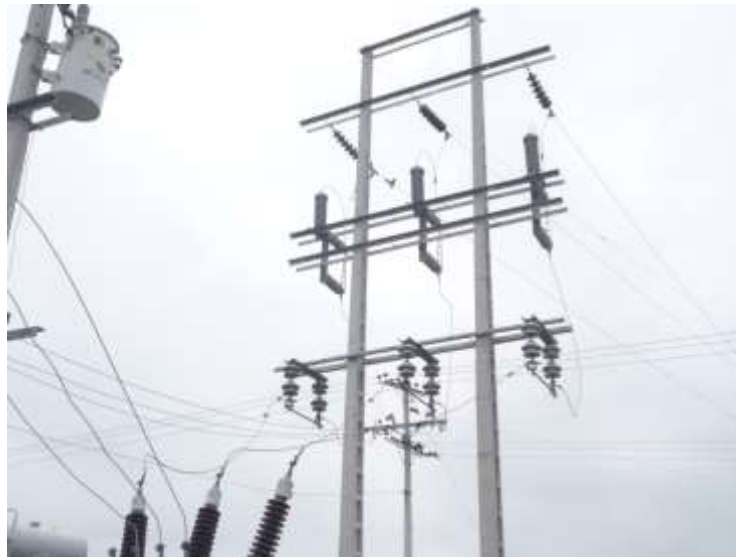
GRÁFICO III- 5 Estructura de Alta Tensión
