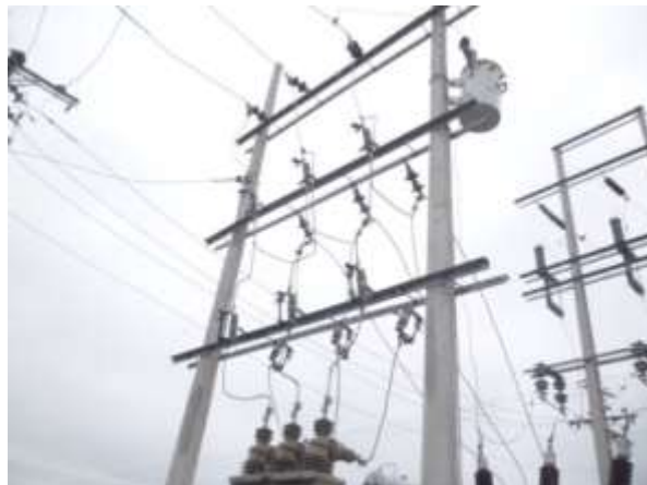
GRÁFICO III- 7 Estructura de Media Tensión
