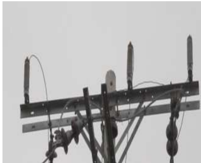
GRÁFICO III- 19 Pararrayos del Lado de Media Tensión
