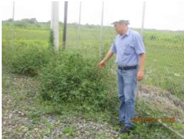
GRÁFICO IV- 3 Maleza dentro de las Instalaciones de la Subestación
