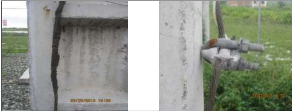
GRÁFICO IV- 2 Puntos de Aterrizaje en mal estado
