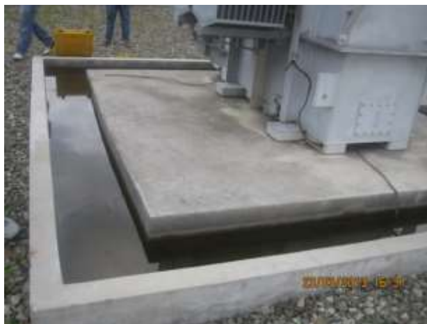
GRÁFICO IV- 5 Sistema anti derrame dentro de las Instalaciones de la Subestación
