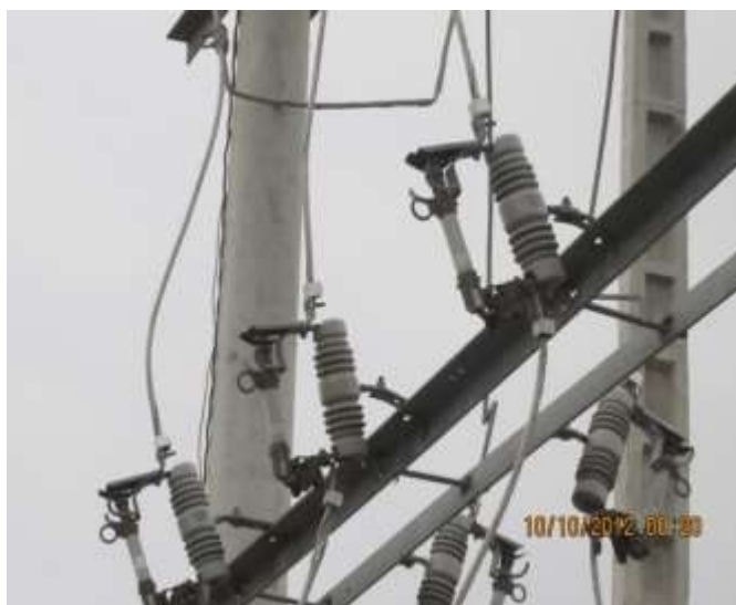
GRÁFICO III- 18 Cajas Portafusibles
