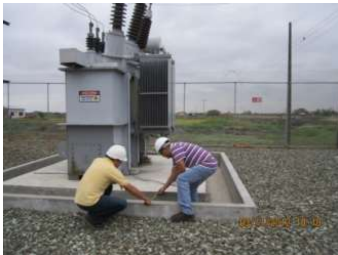
GRÁFICO III- 6 Base del Transformador de Potencia
