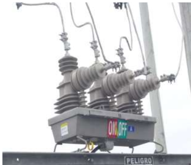
GRÁFICO III- 17 Reconectador Automático Siemens 15 KV
