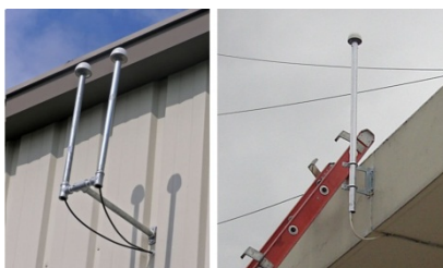
Figura 3.12 Instalación Antena GPS a) Incorrecta. Fuente: SEL b) Correcta. S/E Santa Rosa.
