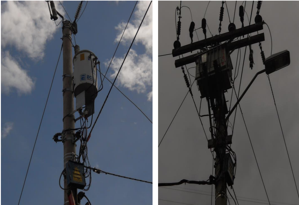
Figura 21. Montaje del equipo Topas 1000.
