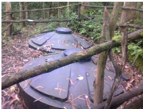
TANQUES DE AGUA
