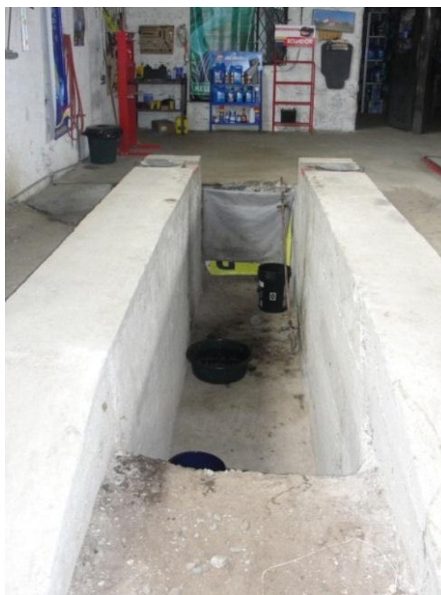
Imagen 2.24 Estado superficial del área de trabajo de Tecno Llanta.
