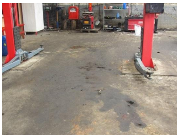
Imagen 2.20 Estado superficial del área de trabajo de Lavadora y Lubricadora Salinas.
