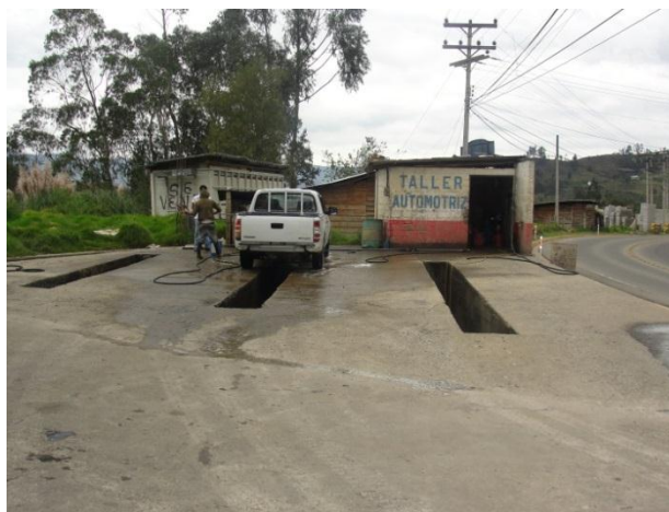
Imagen 2.1 Aislamiento con la avenida y terrenos vecinos del establecimiento Tecnicentro el Mono.
