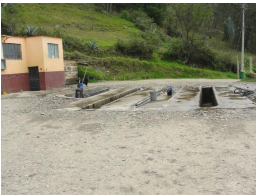
Imagen 2.21 Estado superficial del área de trabajo de Lavadora Car Wash.
