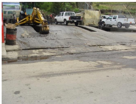
Imagen 2.6 Aislamiento de la Lavadora y Lubricadora Salinas.
