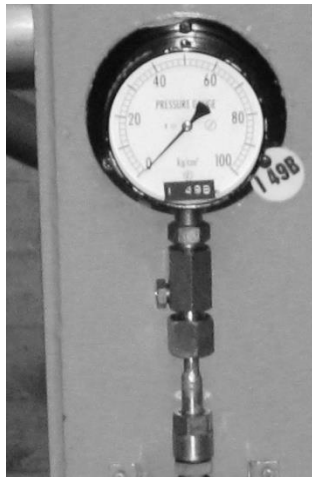
Fig. 4.8 Instrumentos colocados con válvula Manifold y Tag visible. 4
