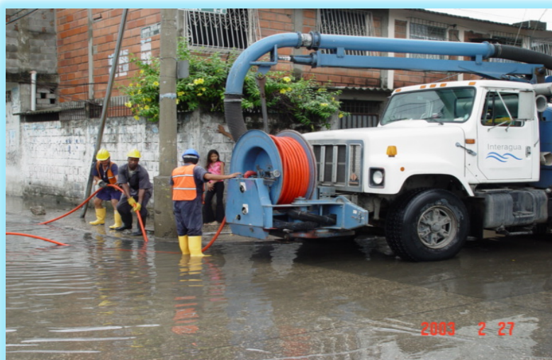
Imagen 2. 2: Tareas de mantenimiento hidrocleaner
