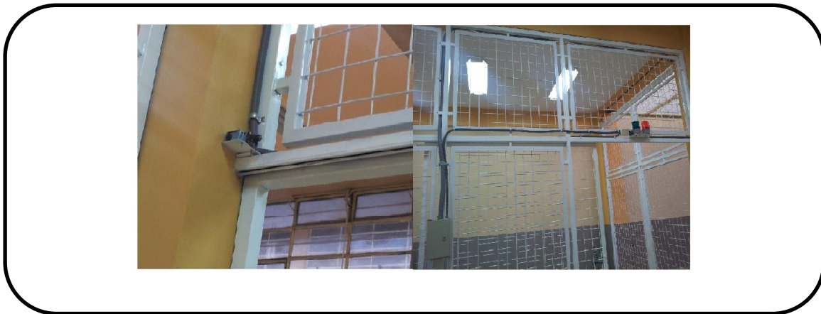
Figura 2.6. Protecciones del laboratorio de Alta Tensión 56
