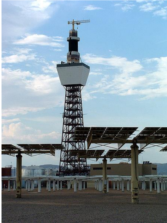
Figura 2.22. Central solar de tipo torre central
