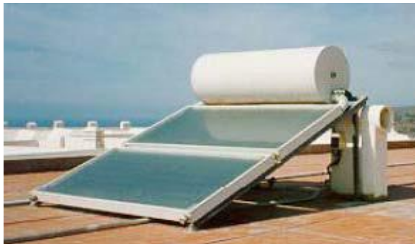
Figura 1.3. Colector solar de placa plana
