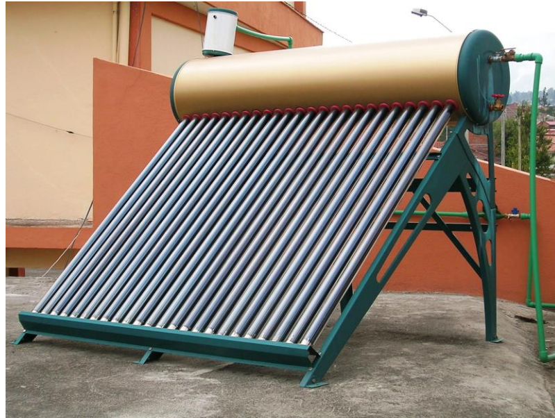
Figura 3.5. Colector solar de tubos de vacío
