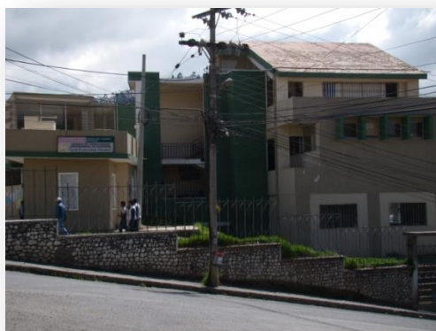
Fig. 61 Colegio Internacional, Ex sindicato de Choferes del Cañar.
