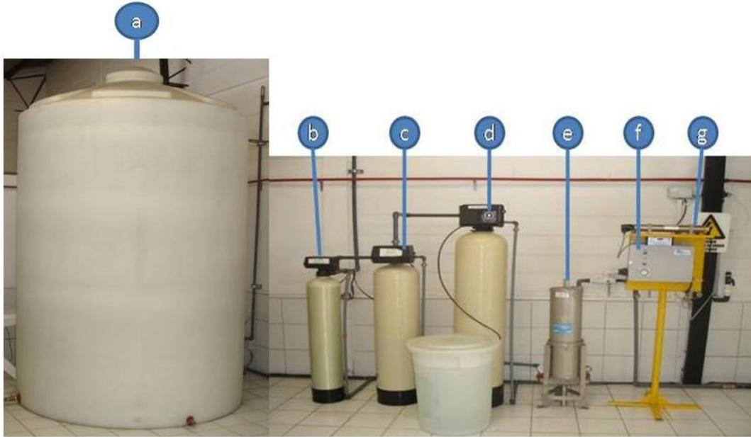
Figura N°1 Filtros purificadores del agua.
