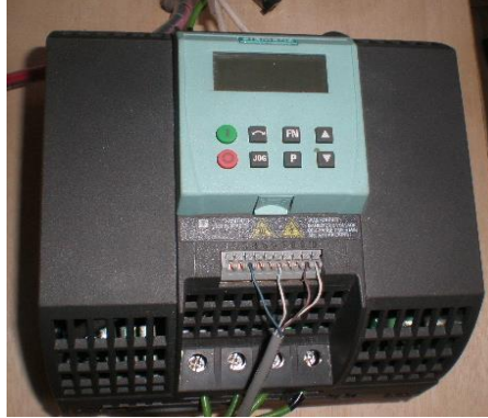
Fotografía 4. 2 Variador de frecuencia Siemens SINAMICS G110.
