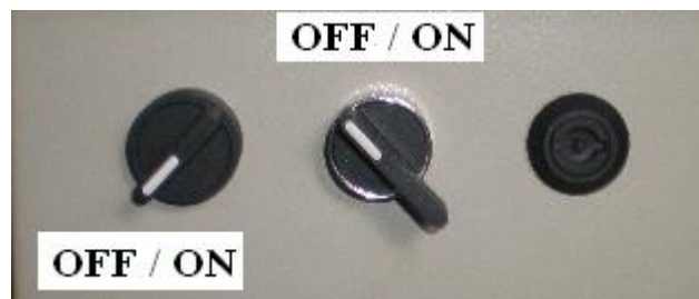
Fotografía 4. 1 selectores de alimentación.
