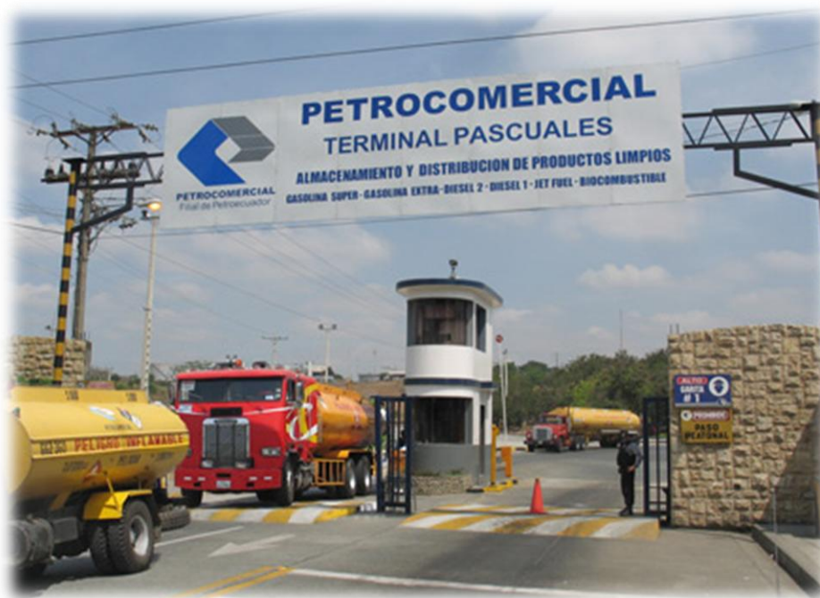
Fig. 3.1: Acceso Terminal Pascuales
