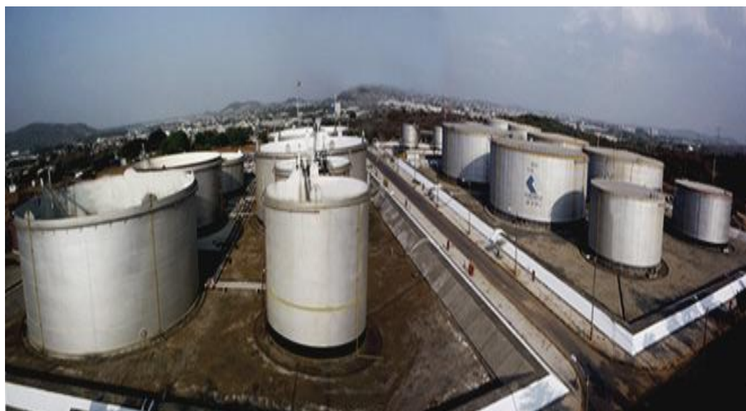
Fig. 3.3: Zona de Tanques de Almacenamiento
