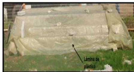
**Figura 1.50. Curado de los elementos**
