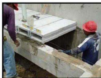
**Figura 1.41. Colocación de las losetas**
