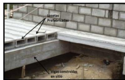
**Figura 1.37. Losetas Prefabricadas**
