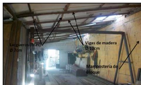
Figura 1.30. Estructura del techo
