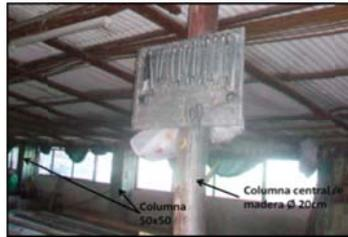
**Figura 1.31. Apoyo de la cubierta.**
