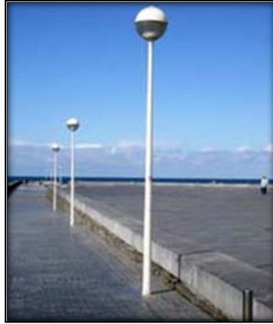
Fig. 1.7. Poste de Plástico 7
