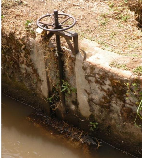
**FOTOGRAFÍA 21.** Bocatoma tipo instalada en la acequia Tabacundo.
