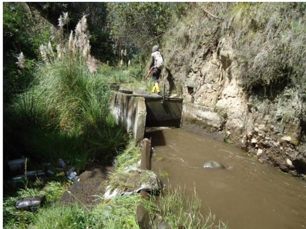
**FOTOGRAFÍA 16.** Conducción principal acequia Tabacundo infraestructura de hormigón con compuerta de regulación de caudales, comunidad de San José parroquia de Tabacundo.
