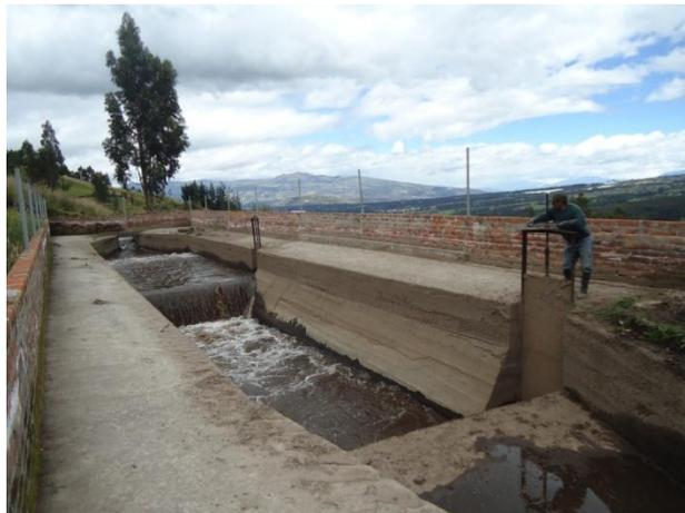
**FOTOGRAFÍA 11.** Conducción principal acequia Tabacundo, infraestructura de hormigón desarenador y regulador de caudal en la comunidad del Prado parroquia de Ayora.
