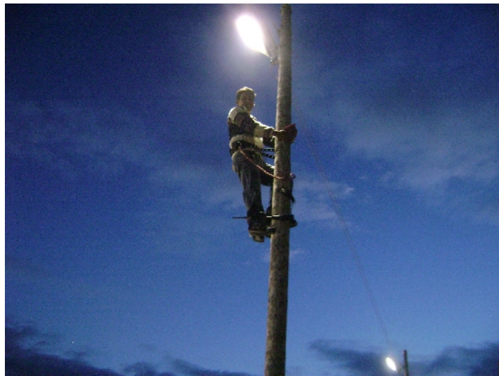
Figura 74-75.- Documentación fotográfica mantenimiento de luminarias
