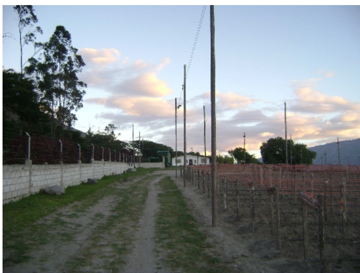
Figura 77.- Reubicación de postes de madera
