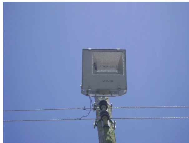
Figuras 42-43.- Luminarias tipo reflector
