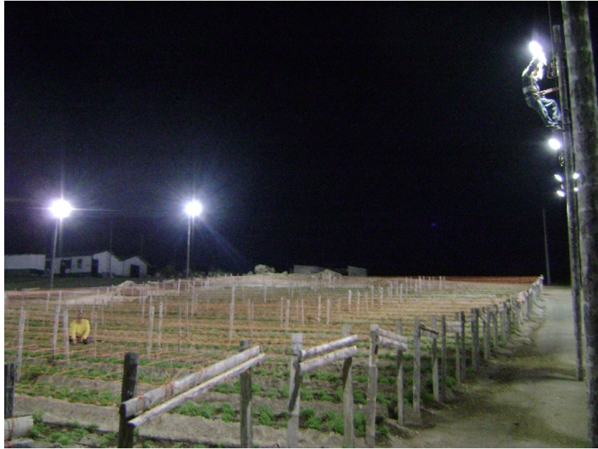
Figura 73.- Ajuste de luminarias sector central del lote
