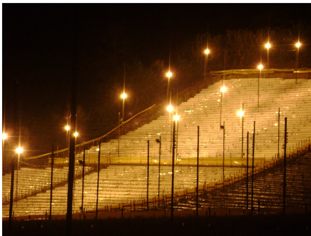
Figura 88.- Documentación fotográfica ubicación final de luminarias
