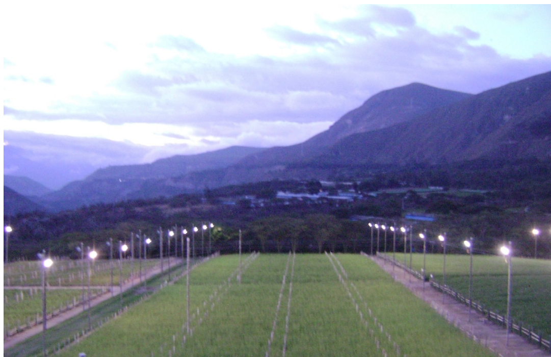
Figura 83.-Documentación fotográfica ubicación final de luminarias
