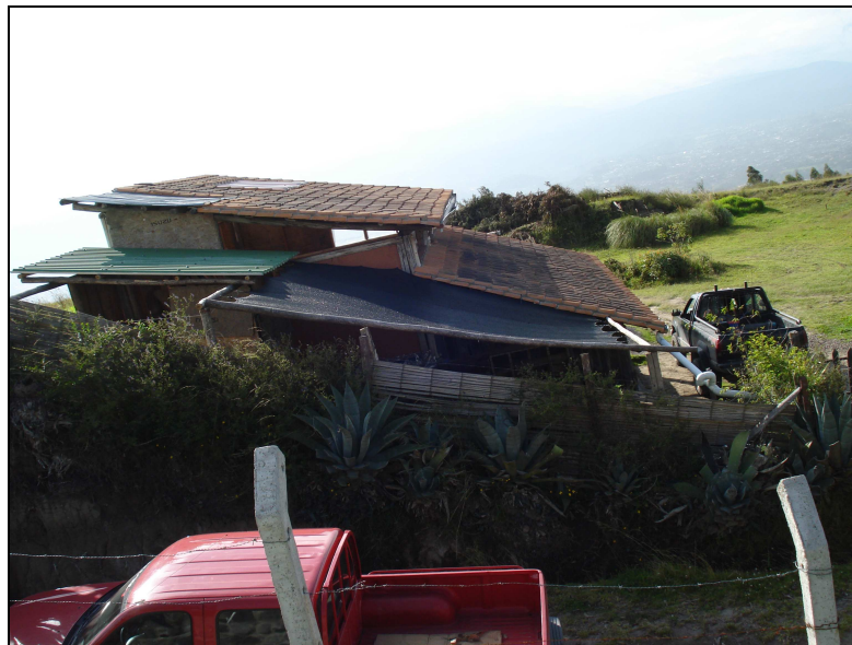
FIGURA 1.24 CAPTACION EN TECHO, QUINTA JOHN DANNE. PROYECTO ECOLOGICO PACAILOMA TUMBACO.
