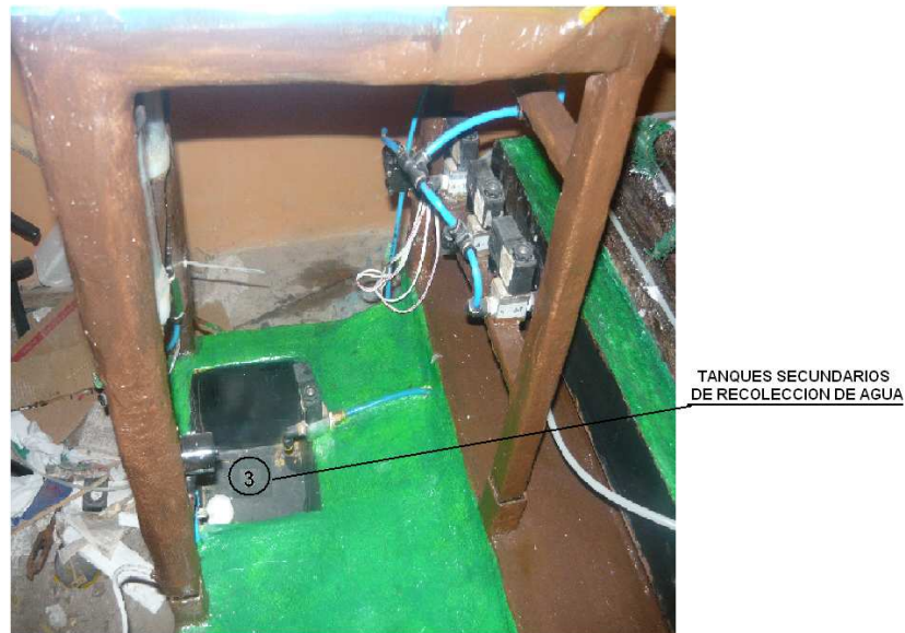
FIGURA 2.44 TANQUE 3 DE RECOLECCION DE AGUA FUENTE: LOS AUTORES
