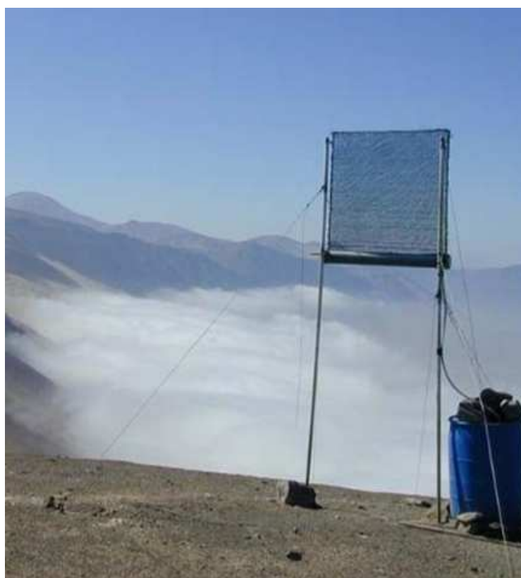
FIGURA 1.30 MALLA RECOLECTORA DE NIEBLA 2. FUENTE PILAR CERECEDA CAPTACIÓN DE NEBLINAS FUENTE: INVESTIGACION PROYECTO ECOLOGICO PAICALOMA TUMBACO
