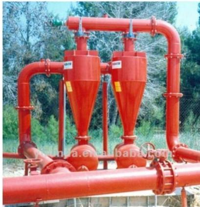
**Gráfica 3.3:** Filtración por medio de un hidrociclón
