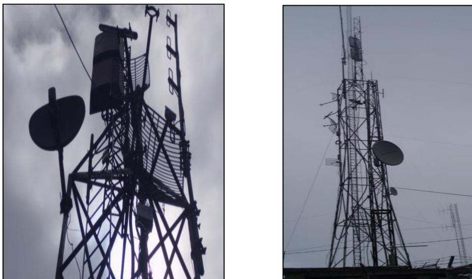
Figura 2. 29 Infraestructura externa Estación Repetidora Buerán, antenas y repetidores.
