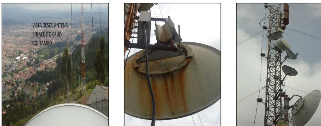
*Figura 2. 26 Infraestructura externa Estación Repetidora Ito Cruz, Link Receiver (Rx 12.7GHz), antenas y repetidores.*
