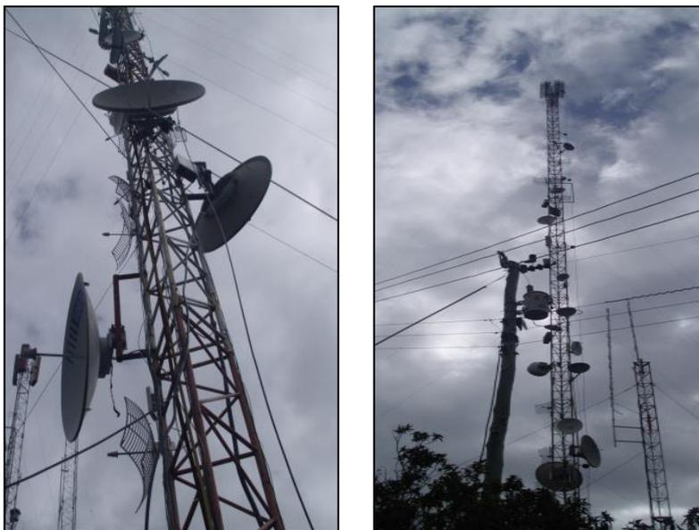
*Figura 2. 23 Infraestructura externa Estación Transmisora Cojitambo, Link Receiver (Rx 12.7GHz), antenas y repetidores.*
