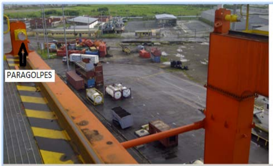
Foto 2.14: Imagen de los Paragolpes en el riel de la Grúa.
