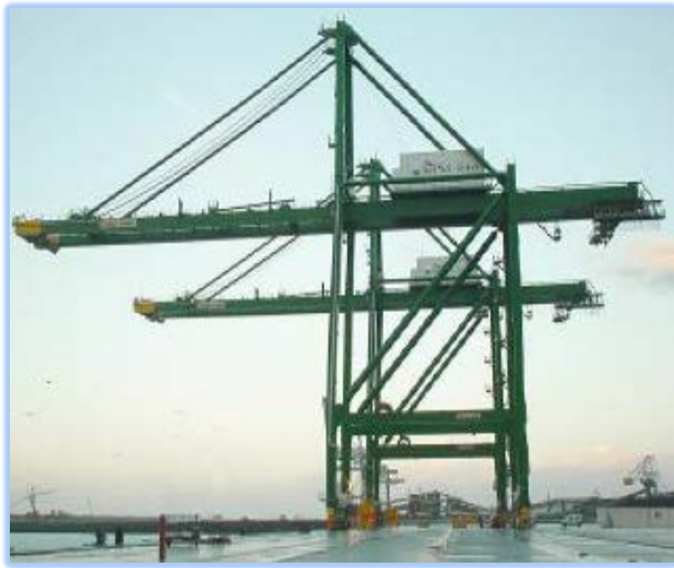
Figura 1.3: Panorámica de la Grúa STS
