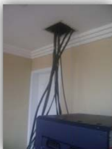
Figura 4.27. Canalización de cables coaxiales y guías de onda.
