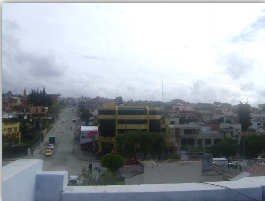
Figura A1.14 Vista posterior del emplazamiento.
