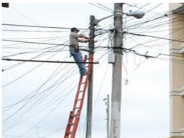
*Figura 4.4 Cables de acometida hacia abonados.*
