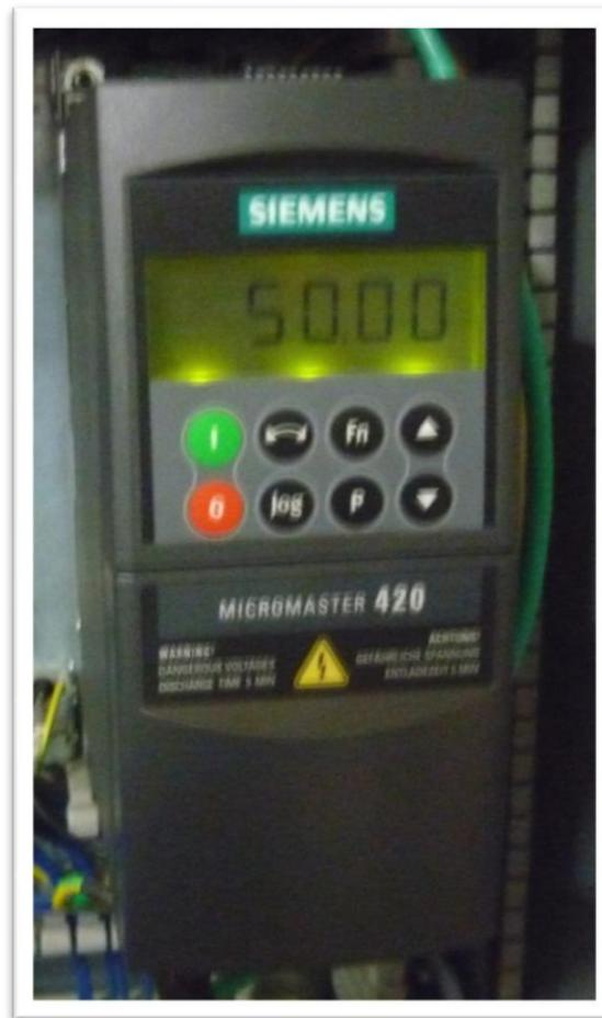
Figura 4-3. Establecimiento de la frecuencia del Conveyor a través del Micromaster 420
