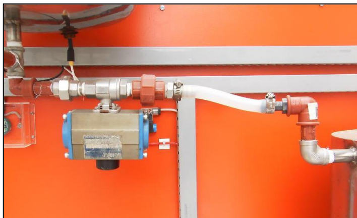
Figura 3.4: Instalación de Válvula 1 Fuente: Autores
