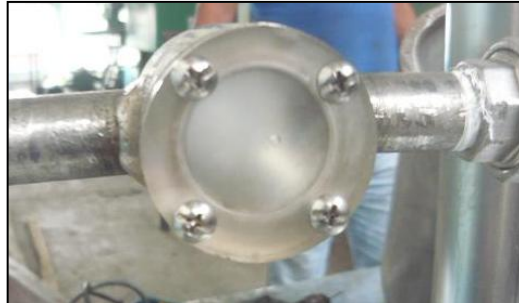
Figura 3.11: Mirilla del Tanque Decantador Fuente: Autores
