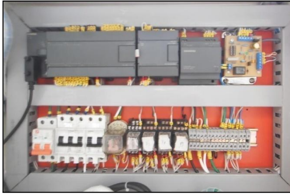
Figura 2.2: Conexión Eléctrica Tablero Principal
