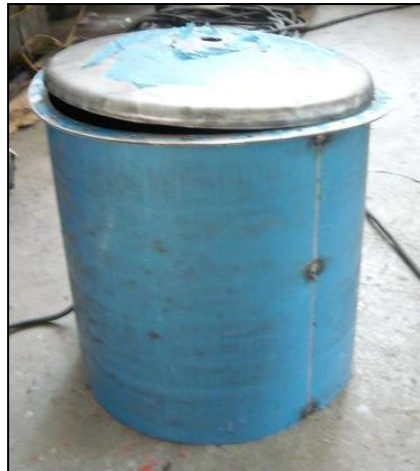
Figura 2.14: Tanque de Reactor en construcción. Fuente: Autores
