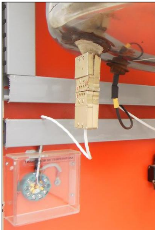
Figura 3.10: Sensor RTD y Transmisor de Temperatura
