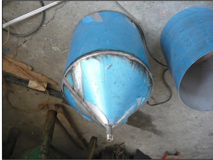
Figura 2.16: Tanque Decantador en construcción.
