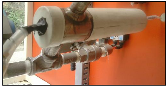
Figura 3.14: Mirilla T. Decantador Vista Inferior Fuente: Autores
