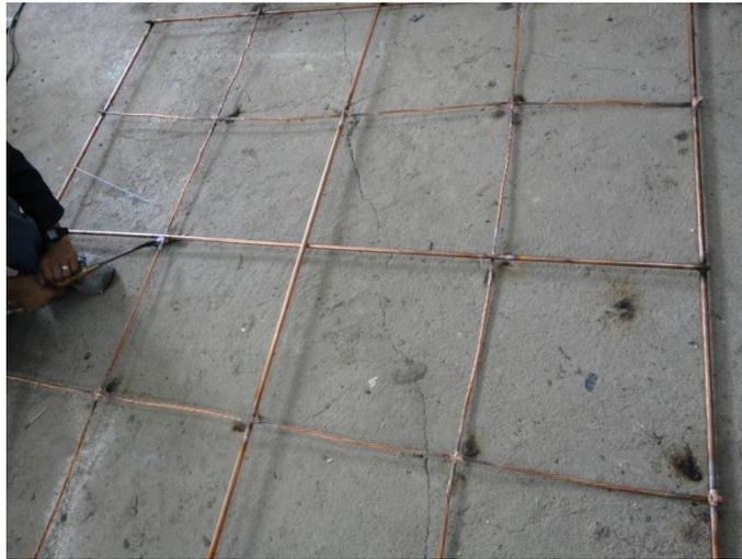
Foto 3-3 (c) Recubrimiento a los puntos de suelda con autofundente al 10% de Ag
