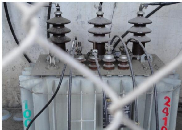
Foto 2-1 Transformador de 100KVA del CTIG
