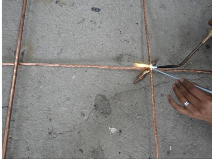
Foto 3-3 (b) Realización de las uniones de la malla mediante soldadura autógena
