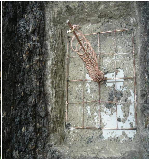
Foto 3-12 (b) Montaje de la malla del SPT3
