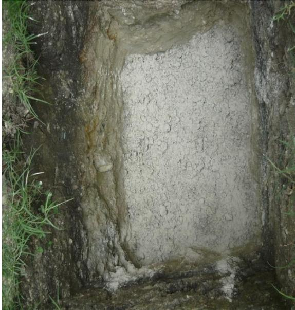
Foto 3-16 (a) Aplicación de la primera dosis de gel al pozo
