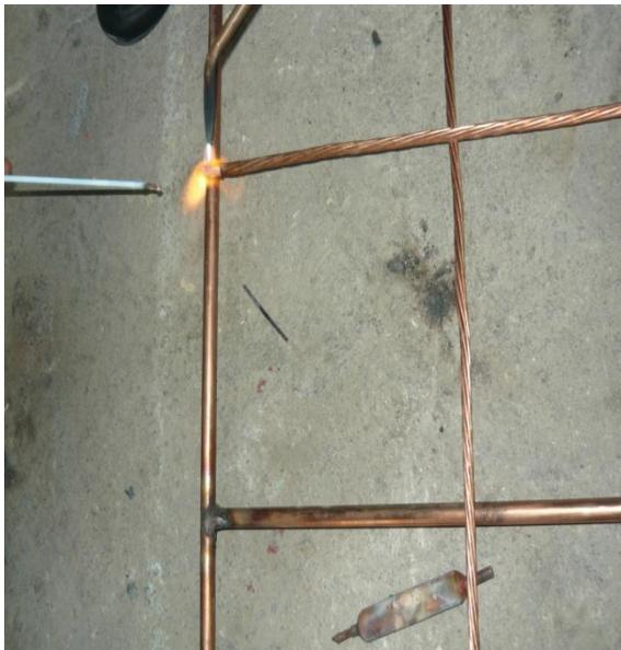
Foto 3-15(a) Inicio de construcción de la malla del SPT7
