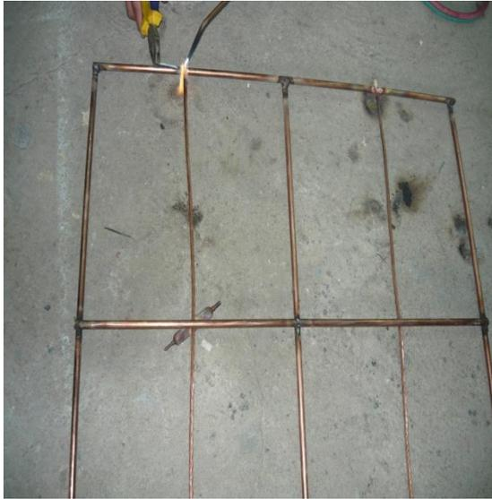
Foto 3-11 (a) Construcción de la malla para el SPT3
