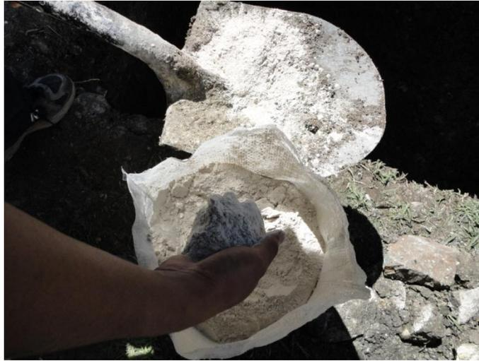
Foto 3-4 (a) Preparación del Gel Benzoelectric
