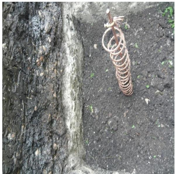
Foto 3-16 Proceso de rellenado del pozo
