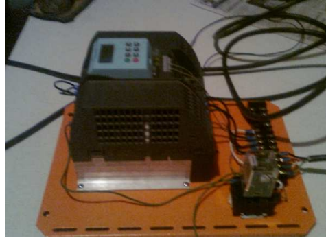
Fig. 79 Imagen de la instalación del variador de frecuencia en el tablero
