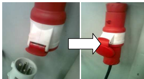
Fig. 19 Conexión de la toma de 220
