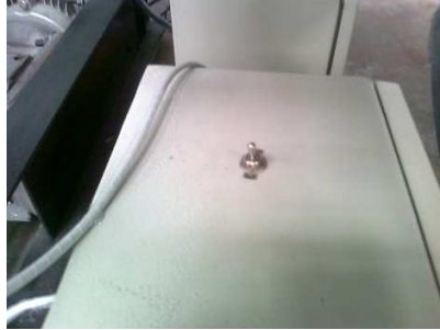
Fig. 21 Interruptor de la caja en donde se encuentran los elementos electrónicos.
