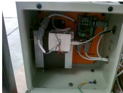
Fig. 10 Comprobación del funcionamiento de los implementos electrónicos
