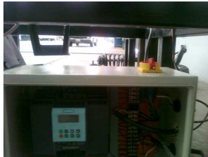
Fig. 81 Imagen de la caja eléctrica con el variador de frecuencia
