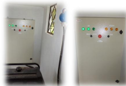
Puesta en marcha módulo de transferencia Automática.
