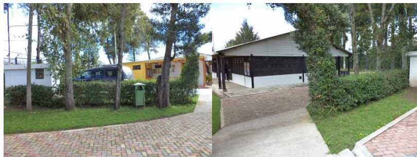
FIG. 27. INSTALACIONES DE ADMINISTRATIVO Y SISTEMAS UESLG
