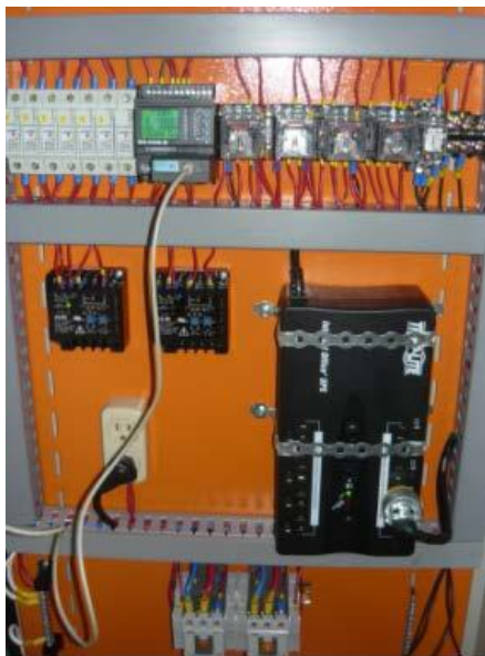
FIG. 60. ESQUEMA REAL CONEXIÓN MÓDULO DE TRANSFERENCIA.
