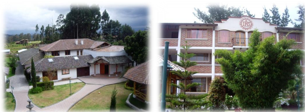
FIG.9.INSTALACIONES UNIDAD EDUCATIVA SAN LUIS GONZAGA
