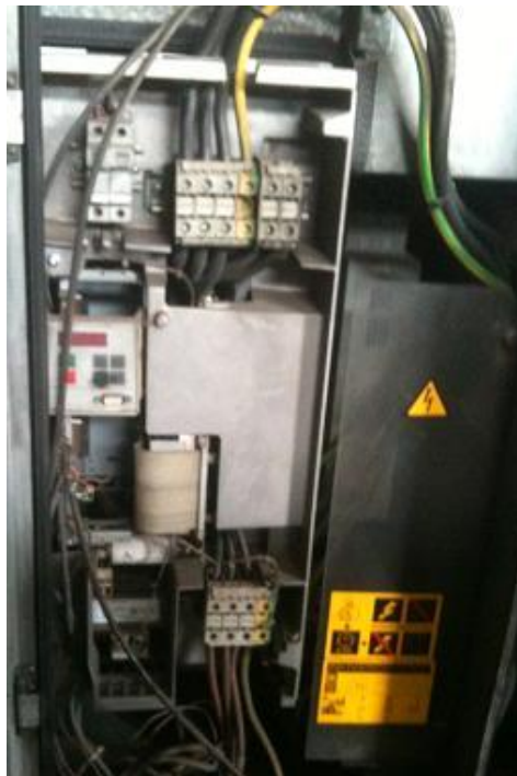
Figura 1.12 Variador de frecuencia Simovort Masterdrive
